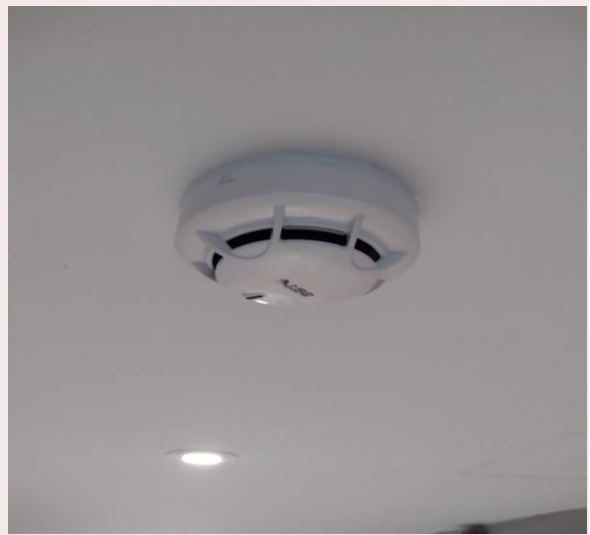
รูปที่ 2.4.6.1-4 อุปกรณ์ตรวจจับควันและความร้อน
