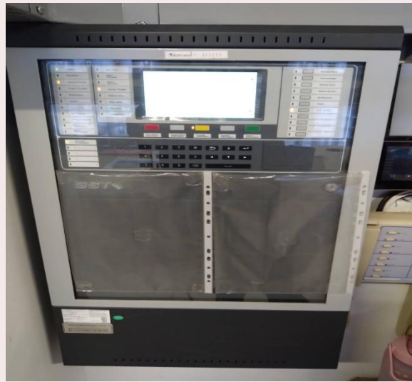
รูปที่ 2.4.6.1-3 แผงควบคุม (FCP)
